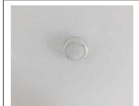
ภาพที่ 2.3-21 เครื่องตรวจจับความร้อน
