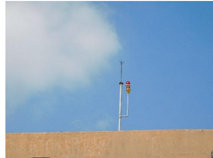
ภาพที่ 2.3-25 ระบบป้องกันฟ้าผ่า
