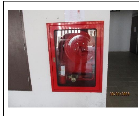
ภาพที่ 2.3-33 ตู้สายฉีดน้ำดับเพลิง
