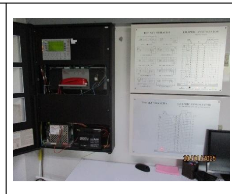
ภาพที่ 2.3-35 ตู้ควบคุมระบบแจ้งเหตุเพลิงไหม้
